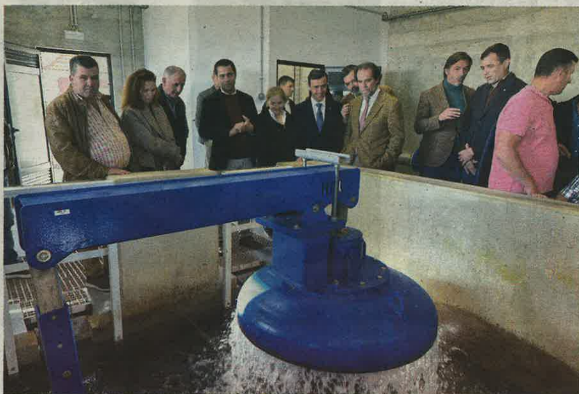
A freguesia dos Canhas passa a dispor de um reservatório para a rega.
