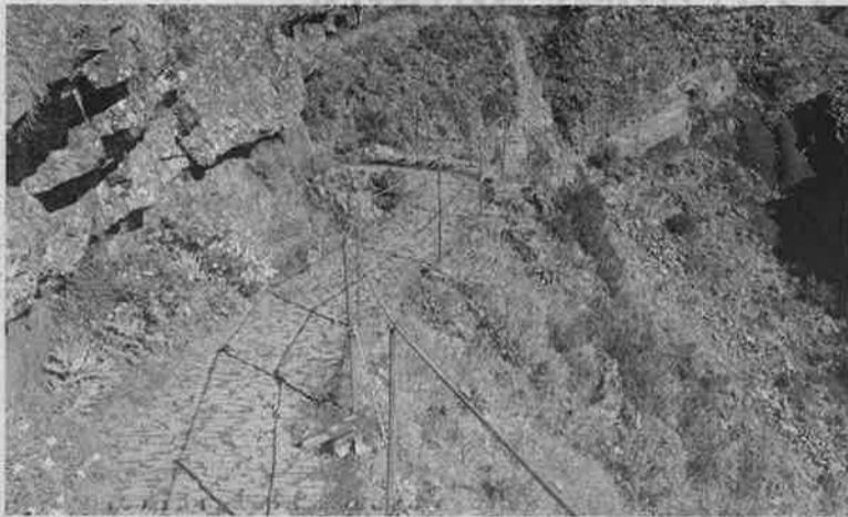
Substituição de prumos e colocação de cabos de aço na vereda.
